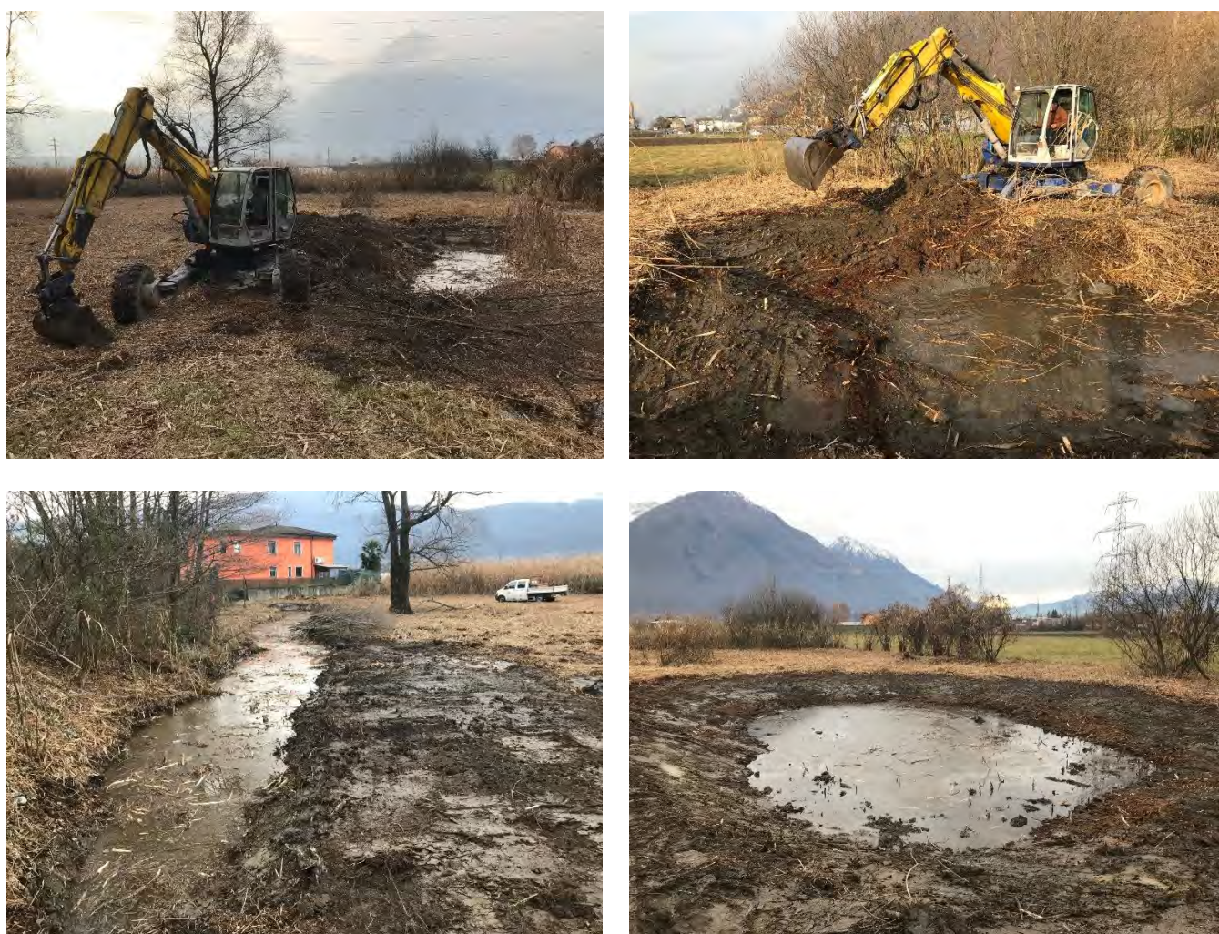
Fig. 3 Corpi d'acqua durante (in alto) e in seguito alle operazioni di spurgo e di taglio della vegetazione (28.02.2019): lanca (in basso a sinistra) e stagno (in basso a destra)
